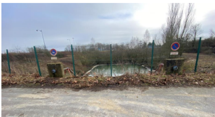
Vue de la réserve incendie
